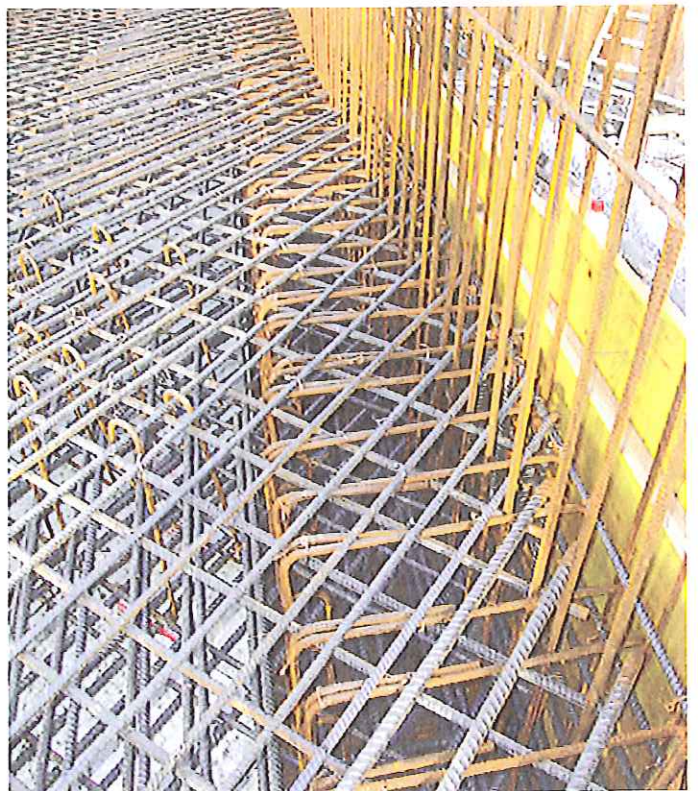
Ohne Armierungsstahl gehts nicht: Bewehrungsgitter beim Wankdorf-Kreisel in Bern. Foto: pd
